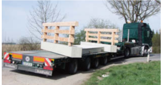
Anlieferung der kompletten Brückenplatte
