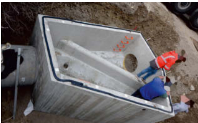
Trennbauwerk in Miesbach
