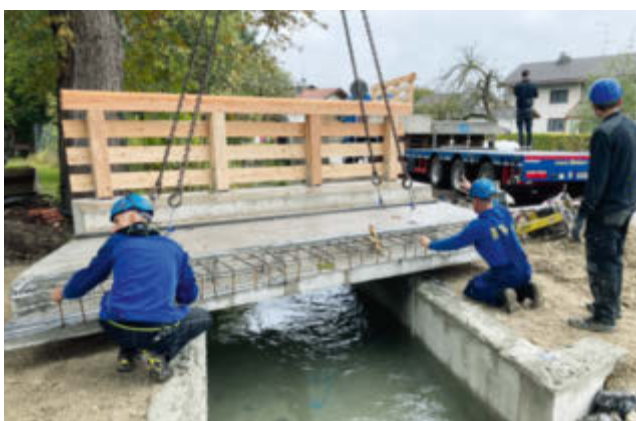
Versetzung auf Mörtelbett für Lastausgleich
