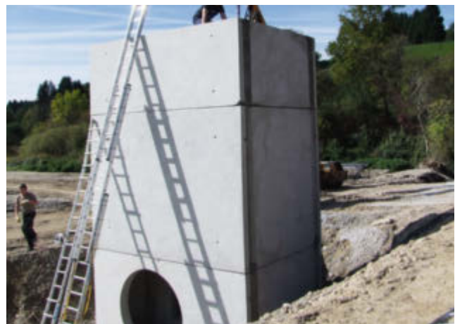
Auslaufbauwerk in Bad Endorf
