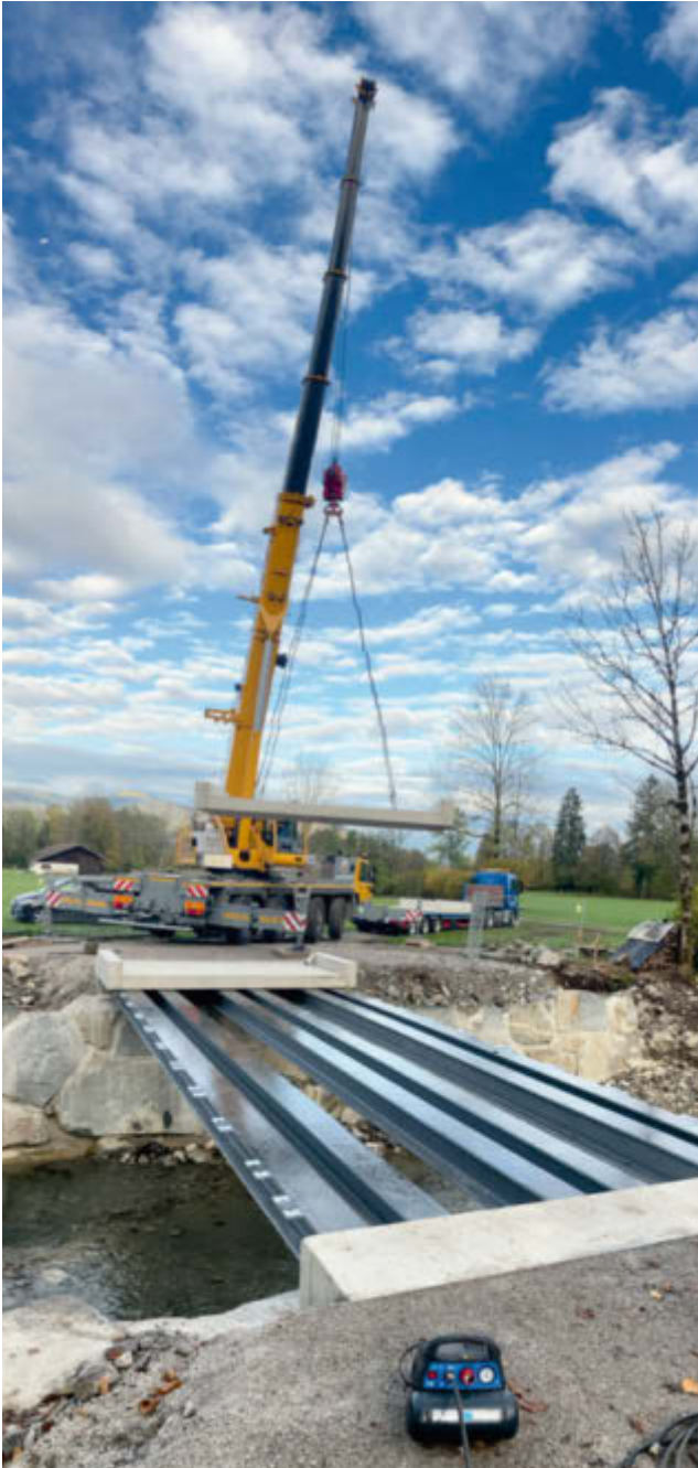
Oberbau aus 6 Fertigteilelementen
