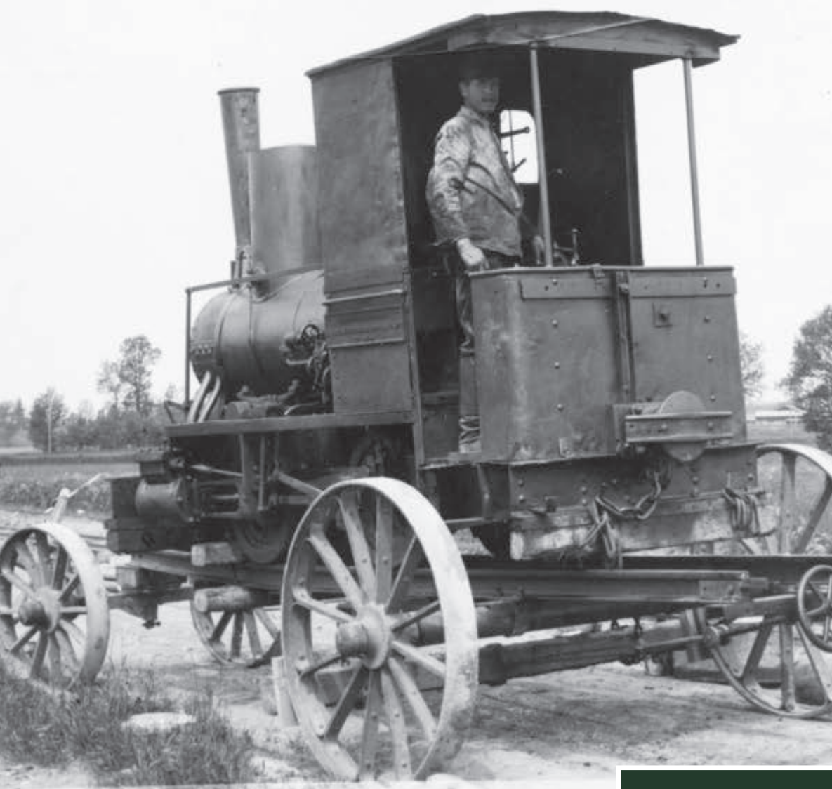
LOKOMOTIV TRANSPORTWAGEN z. KANALBAU D. ELEKTWERK ROSEN
