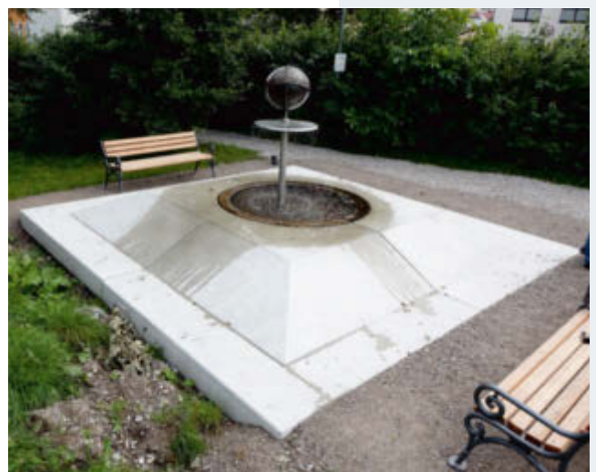
Brunnen in Sichtbeton
