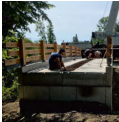
Plattenstoß mit Verschlaufung
