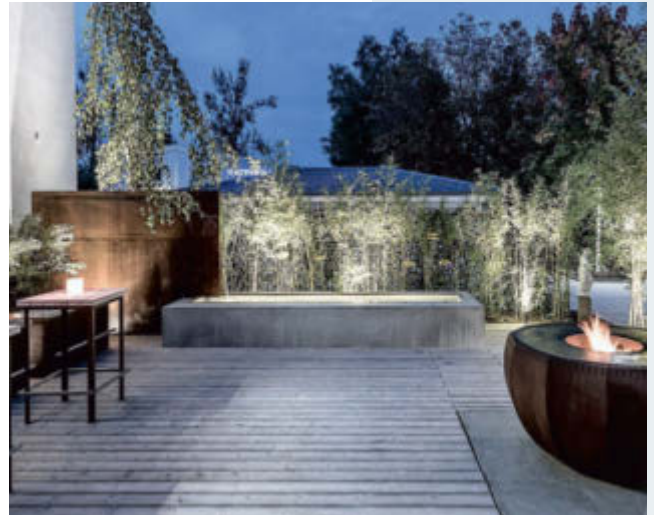
Wasserbecken in Sichtbeton
