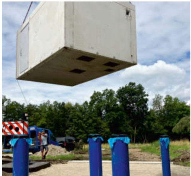
Betonfertigteiltbauwerk für die Wasserversorgung
