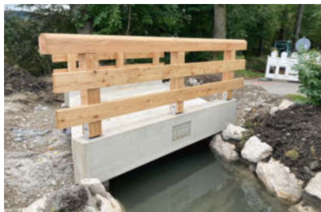
fertig montiertes Geländer in Balkenschuhen
