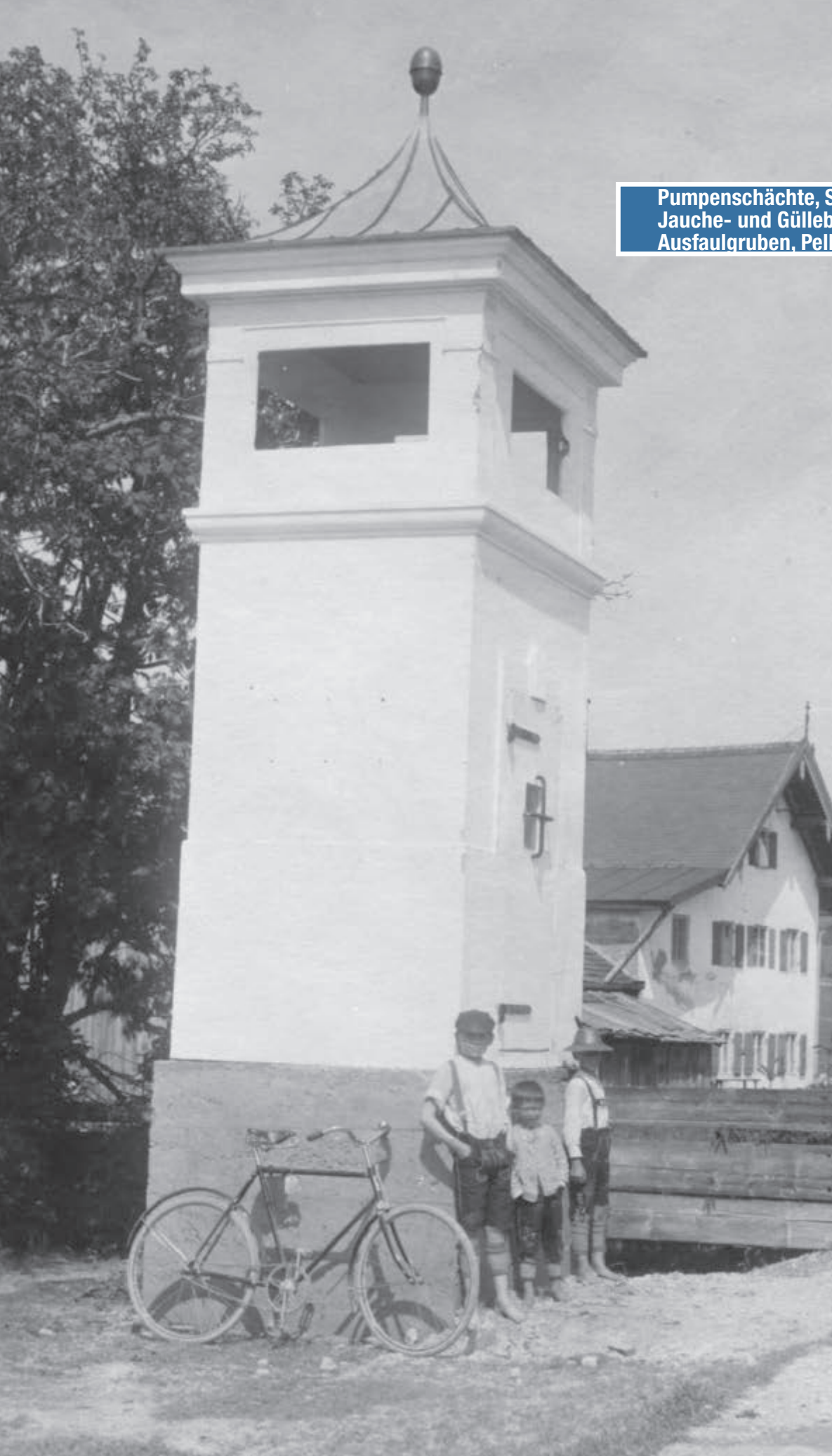
Eine fertige Trafostation aus dem Jahr 1913.
