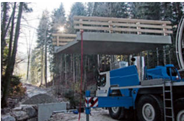
Versetzen der einteiligen Brückenplatte
