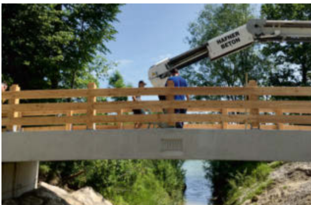
Brückenplatte mit Überhöhung, Jahreszahl
