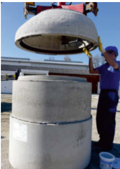
IDLA-Schachthals mit Gleitmittel versehen.....
