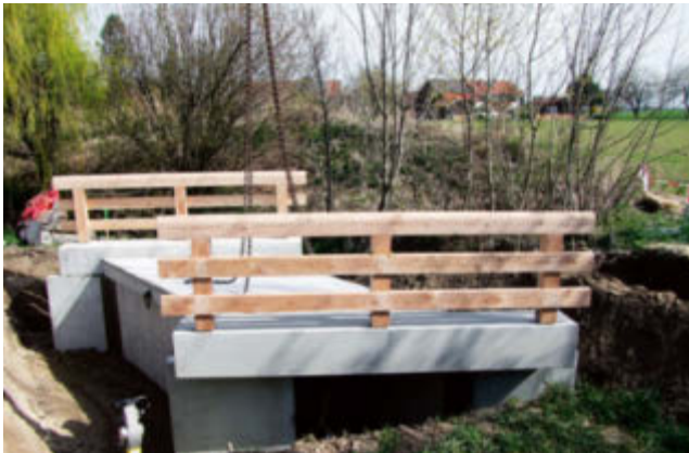
Spannweite 192 cm, Fahrbahnbreite 350 cm
