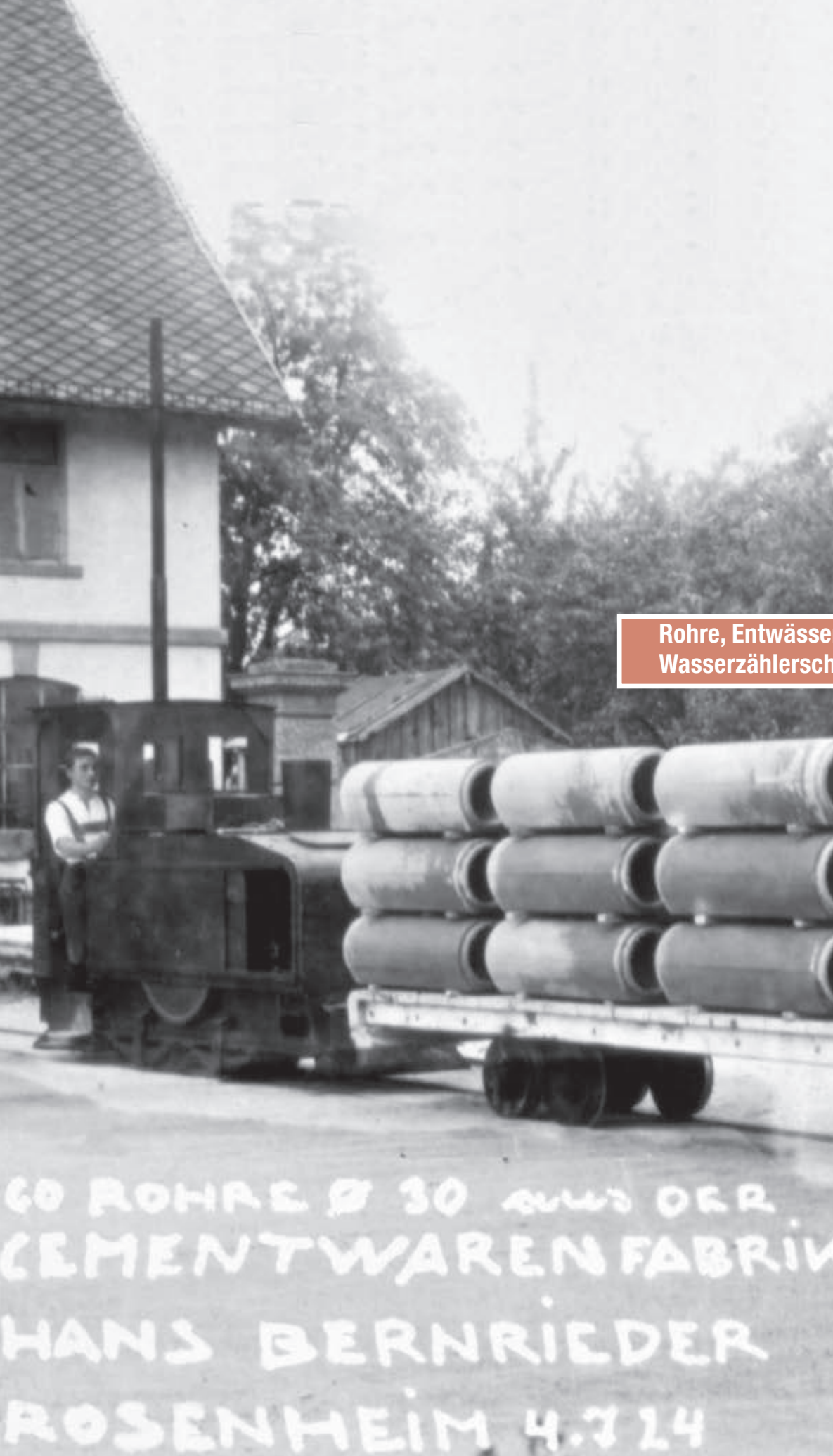
Transport der frisch betonierten Rohre mit einer kleinen Diesellok zur Lagerhalle.
