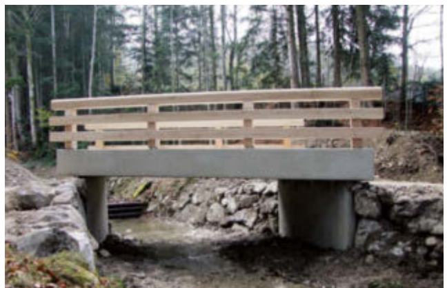
Spannweite 437 cm, Fahrbahnbreite 300 cm, Kreuzungswinkel Bach / Straße 66°
