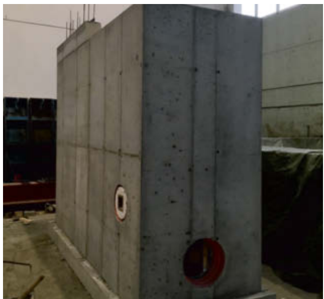
Maßanfertigung mit einer Systemschalung in druckwasserdichter Ausführung
