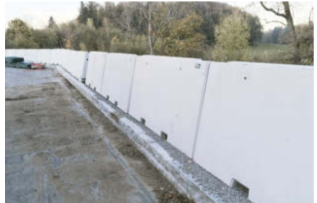
Stellwände Grundteile mit 2 Stapleraussparungen 20/10 cm
