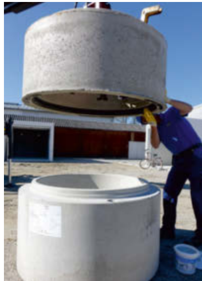
IDLA-Schachtring mit Gleitmittel versehen.....
