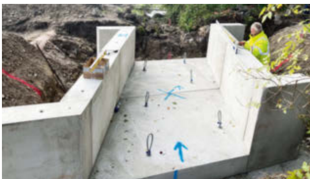
Unterbau in Rinnenausführung
