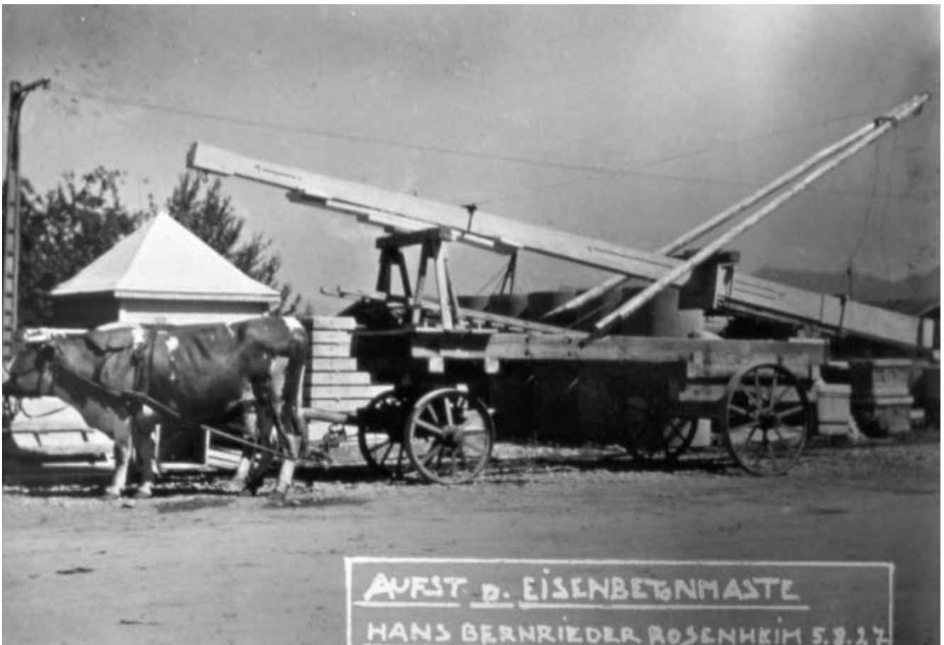
Transport- und Aufstellungswagen mit Ochsengespann für Stahlbetonmasten. 1927
