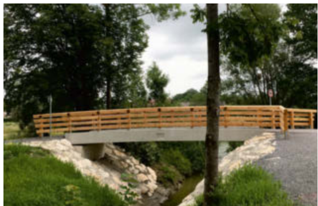
und optisch ansprechendem Lärchengeländer
