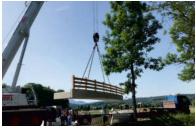
Versetzung mit dem Autokran...
