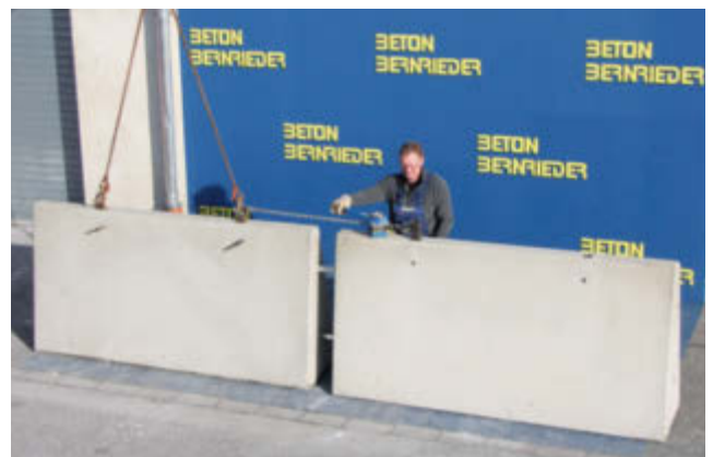
Zusammenziehen der Trennwände mit Kettenzug oder Spanngurt beim Versetzen.
