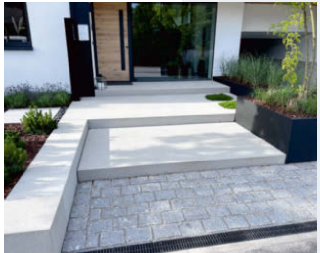
Eingangsbereich mit großen Betonplatten gestraht
