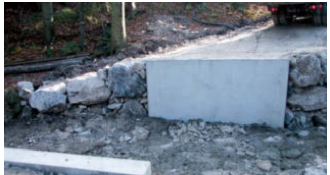
Hinterfüllung der Widerlager, Bachausbau
