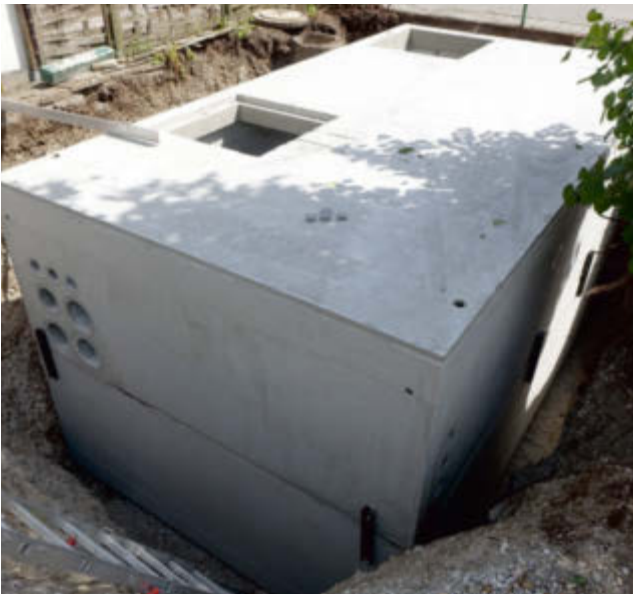
Technischsacht aus 2 monolithischen Schalen, die mit Dichtband wasserdicht verbunden sind
