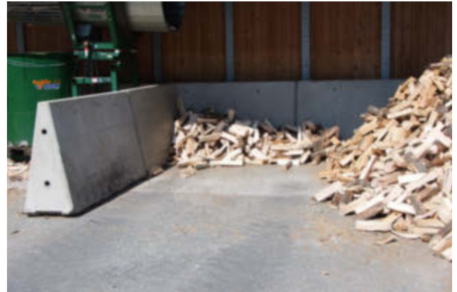
Trennwände zur Lagerung von Holzscheiten
